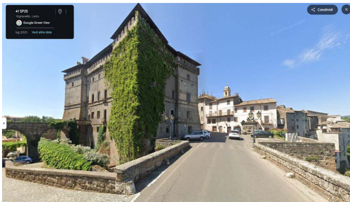
(*) Immagine tratta da google street view.
